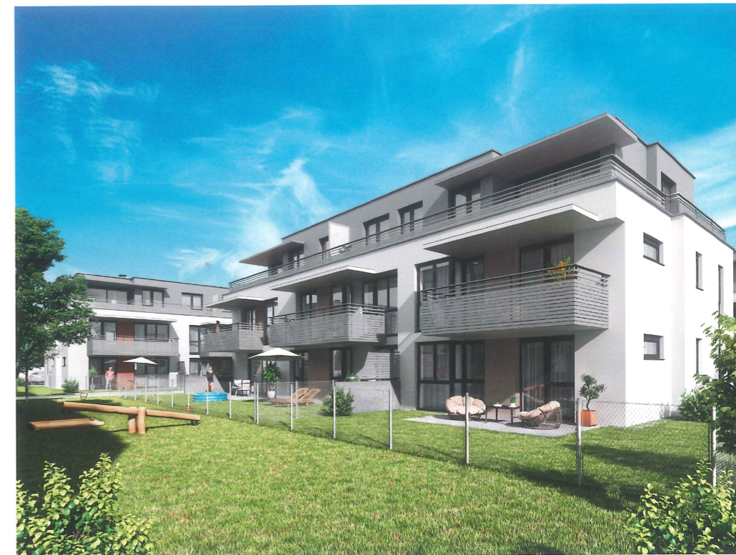
Gössendorf überzeugt durch seine perfekte Infrastruktur und die Nähe zu Graz.
