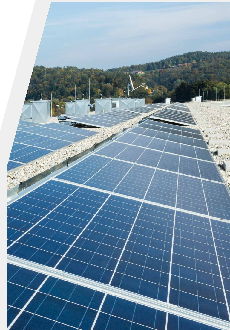
Auf dem Dach des Lendparks entsteht eine der größten Photovoltaik-Gemeinschaftsanlagen der Steiermark
